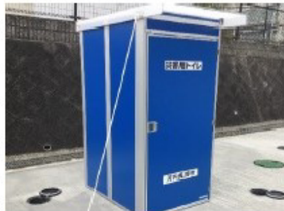
マンホールトイレ(完成)
