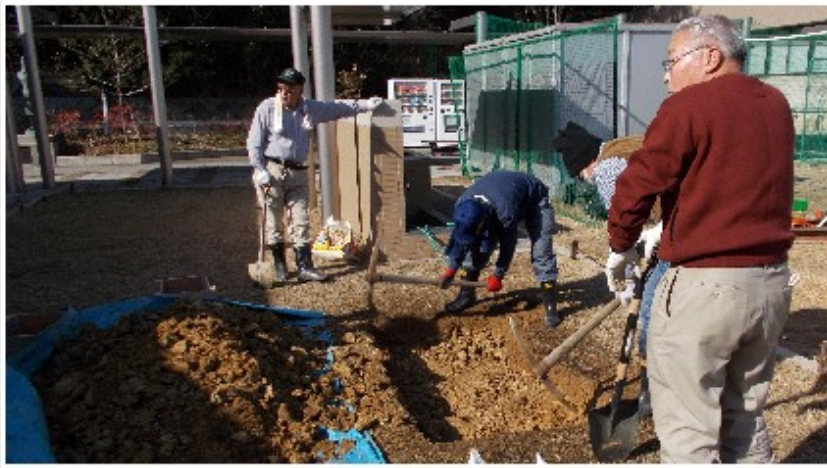
2月16日（金）基礎工事（大阪暁光高校）
