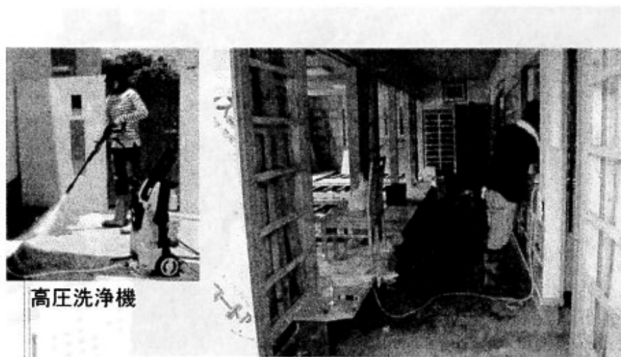
浸水した室内の洗浄
